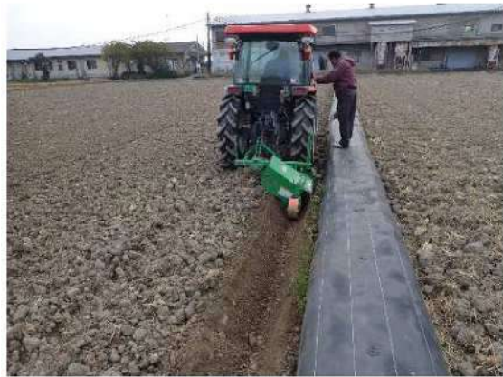
図3-5 明渠の施工
